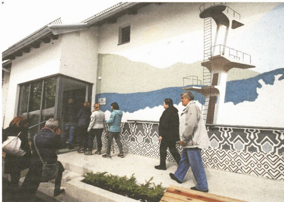
Nova najemna stanovanja za starejše so urejena v stavbi, kjer so bili pred rekonstrukcijo prostori gostinskega lokala in pisarna društva upokojencev. / Foto: Gorazd Kavčič
